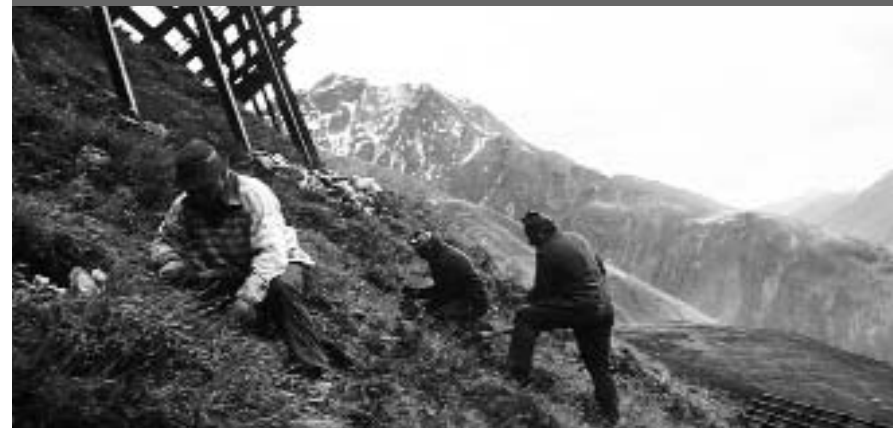
Aufforstungsarbeiten im Schutz der technischen Ambruchverbauung (1995)
