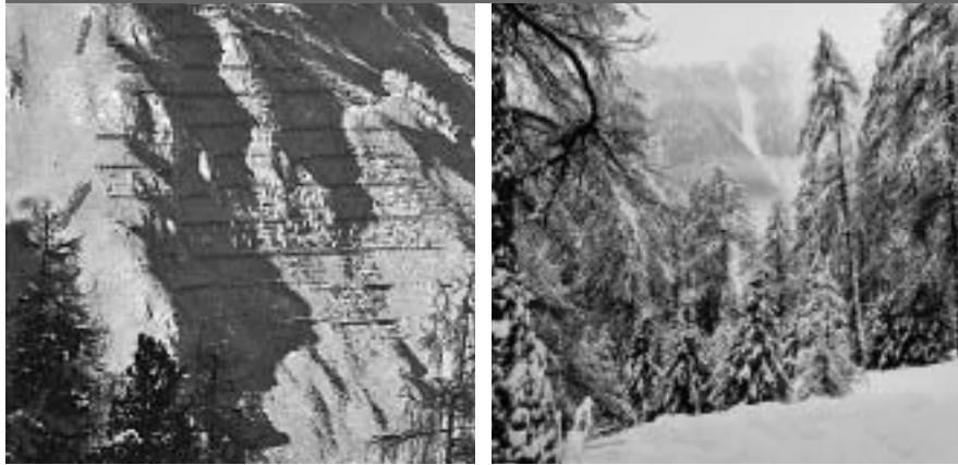
Lawinerverbauung Mot Salatsch (1984–1987) an der gegenüberliegenden Talseite mit Aufforstungen und neuerer Ergänzung mit temporärem Lawinerverbau Typ Rempar Grischun (Mettler) sowie Wild- und Gletschneeschutz. Hier entsteht ein neuer Schutzwald (li); Schutzwald God Grond mit gelungener Verjüngungseinleitung (re)
